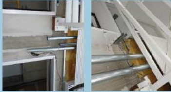
Façade double-peau - chantier de l'immeuble l'Arbre blanc à Montpellier - photos P. Lhermet
