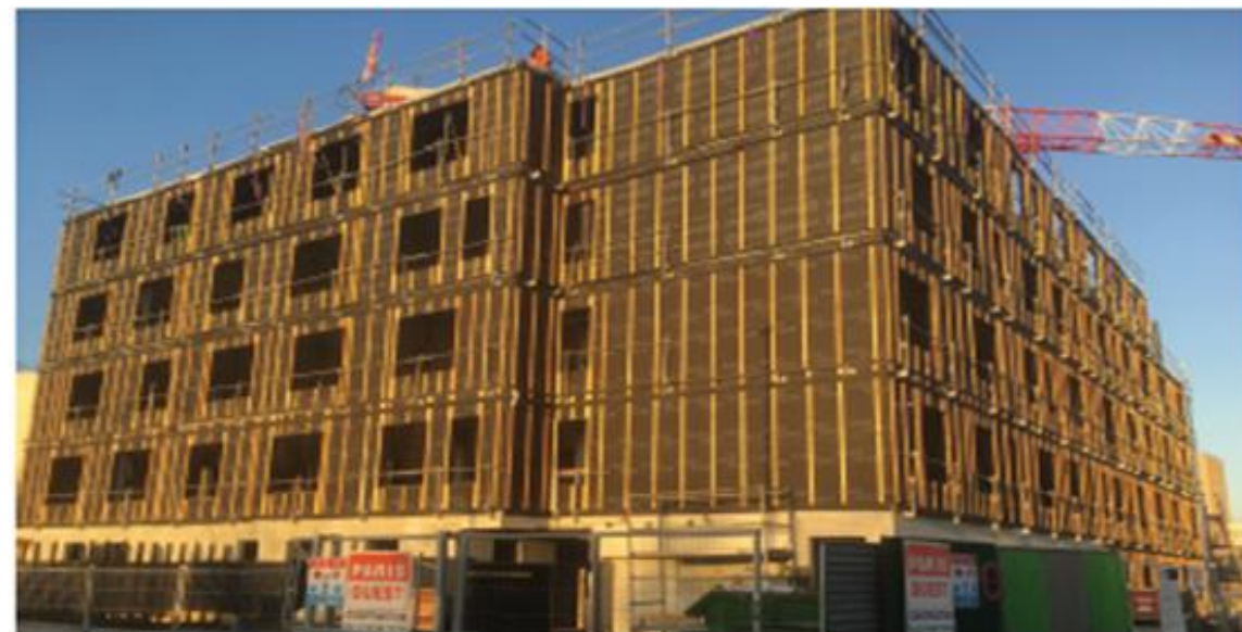
Fin du gros-œuvre avant bardage de finition
